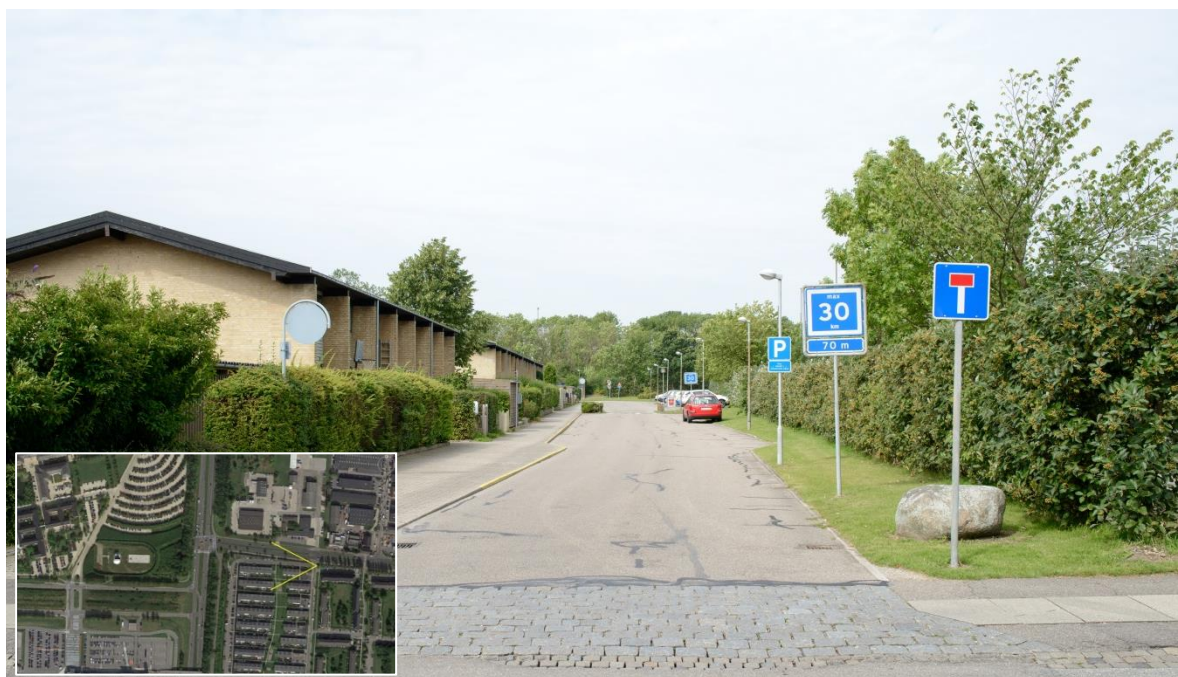
Figur 10-14. Fotostandpunkt 5. Rønnevangshusene/Egevangshusene, eksisterende forhold.
